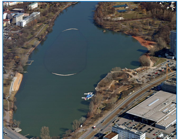
Am Unteren Wöhrder See wurde eine Unterwasserinsel gebaut.
